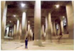
地下放水路のようす
