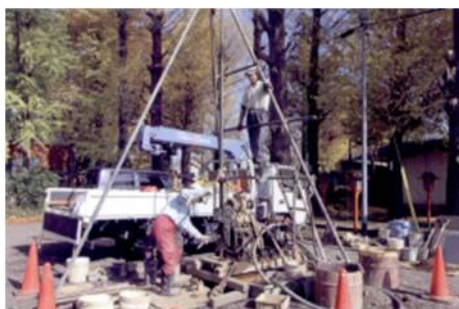
ボーリング調査のようす
