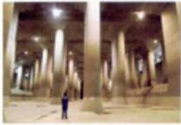
地下放水路のようす
