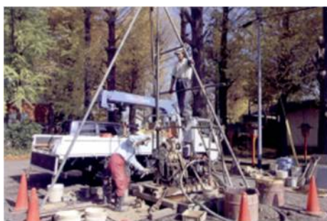
ボーリング調査のようす
